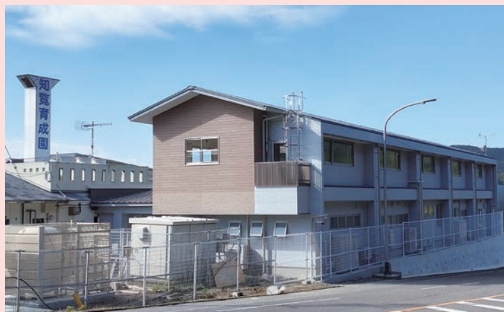
指宿スカイライン側からの外観
